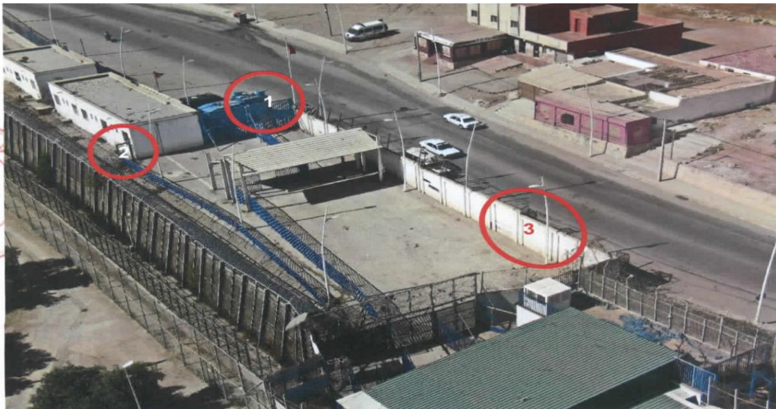
Detalle fotográfico del patio marroquí donde se señalan las puertas forzadas y la zona de la verja que se derrumbó.
